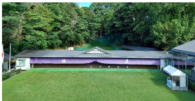
中央道場 2階控えから
